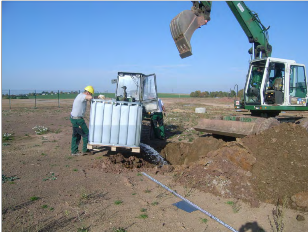
Bild 3: Beispiel für das Befüllen einer Schurfgrube
