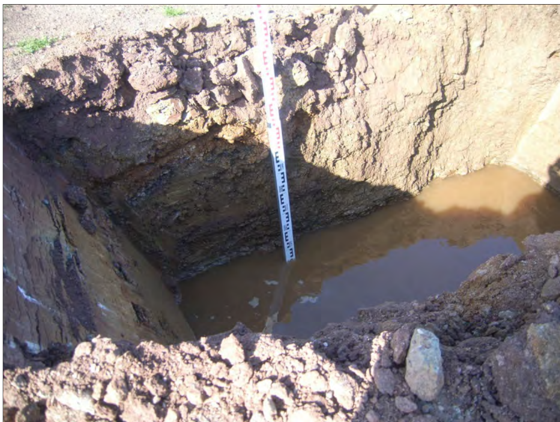
Bild 4: Durchführung Sickerversuch, Messung der Wasserstandsabsenkung
